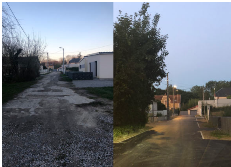
Rue du Routil - Avant / Après
